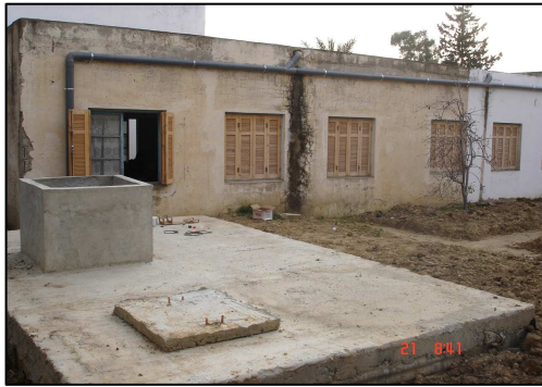
الفسقية وقنوات حصاد مياه الأمطار عبر الأسطح
